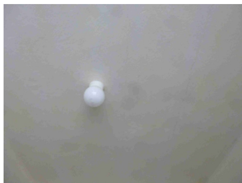
Obr.č.16 Prvky systému umelého osvetlenia
