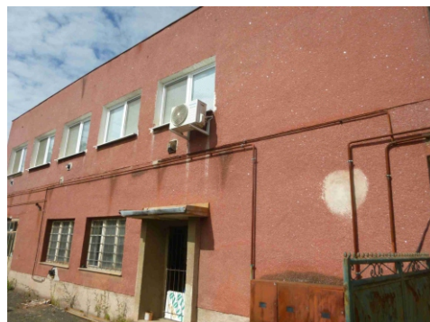
Obr.č.2 Pohľad východný
